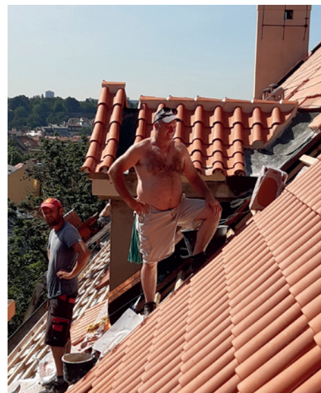
Pokrývači při práci s prejzovou krytinou na střeše kláštera Emauzy.
