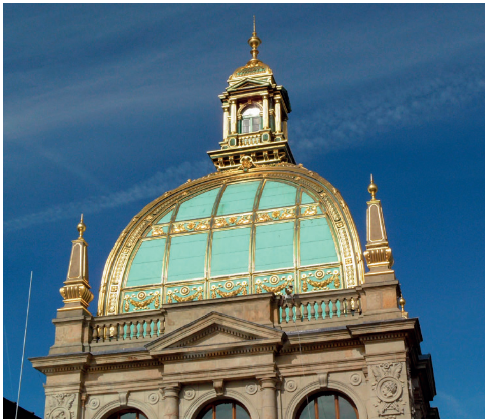
Vysněnou zakázkou byly repase klempířských prvků na střeše Národního muzea.
